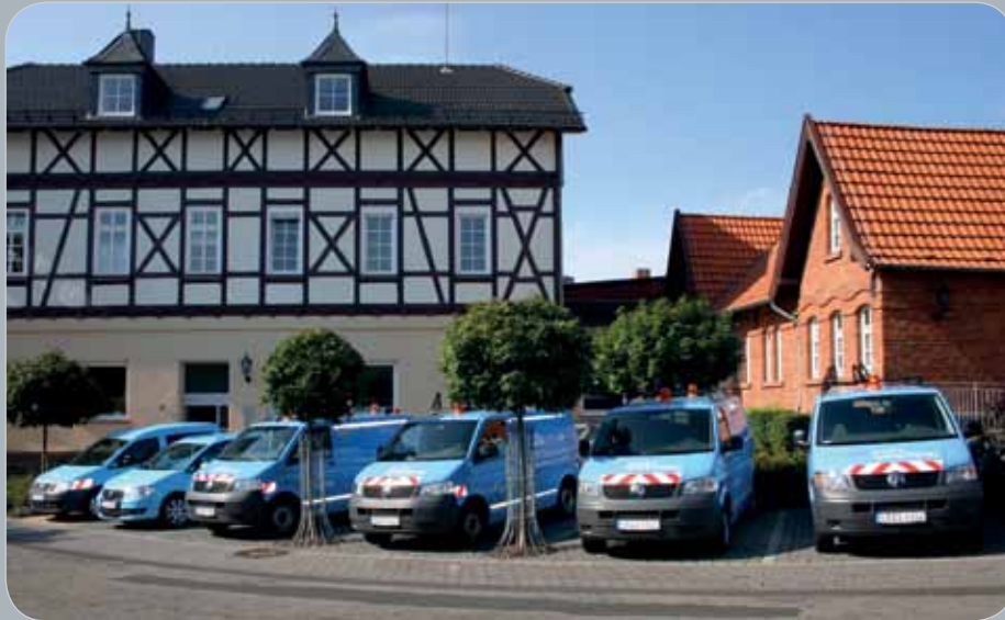
Aussenansicht der Stadtwerke Lauterbach | Bildquelle: Stadtwerke Lauterbach
